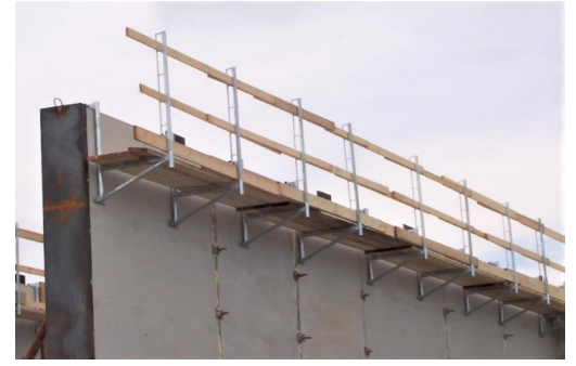
Betonier-Konsole f. Ft.-Wände
