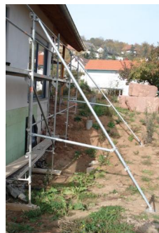
Stufenlos verstellbare Schrägstütze
